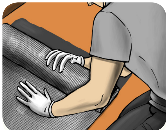
▶ Докато първия слой MAGIFLEX е още пресен, поставете мрежата MAGINET , като я притискате
