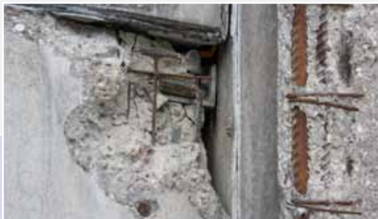
Деградация на бетона върху структури, в контакт с морска вода и изложени на хлоридна атака.
