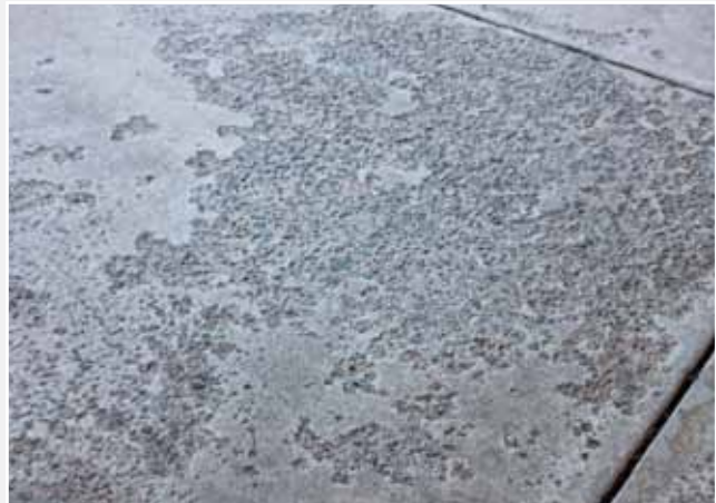
Отлюсване на бетон, причинено от увеличаване на обема на водата, след излагане на цикли на замръзване-размръзване.
