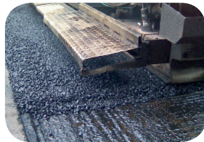
Полагане на асфалтов дренажен слой
